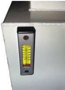
Индикатор уровня масла бака гидравлической системы
